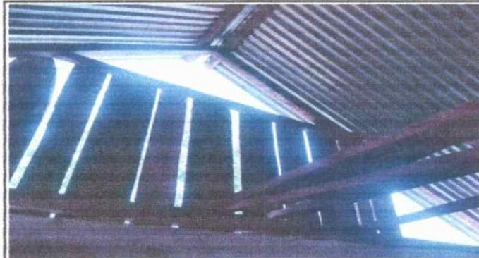
Foto 9: MODULO 2. Sustitución de madera a block en el mojinete y costaneras de madera a metal.
