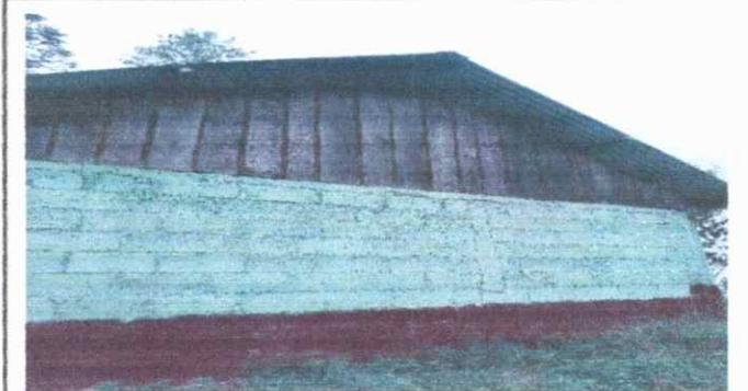
Foto 1: Cambio de madera a block del mojinete y repello de la cocina. Módulo 2.
