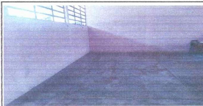
Foto 5: Sustitución de piso de torta cemento a piso cerámico, aula No.1. MODULO 1. Se observa las paredes del aula.
