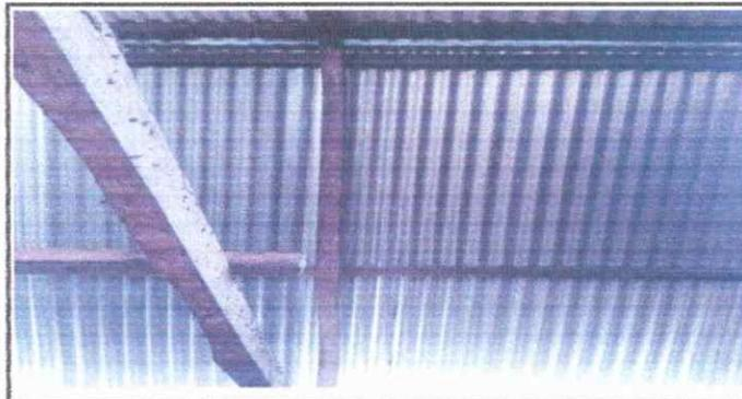
Foto 11: MODULO 2. Sustitución de lámina de zinc a lámina troquelada calibre 26 de la cocina.
